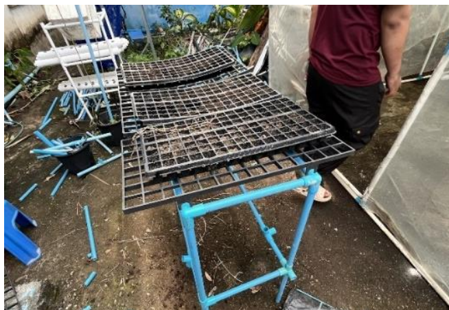
รูปที่ 3.9 ออกแบบฐานวางถาดเพาะปลูกต้นกล้าภายในโรงเรือน
