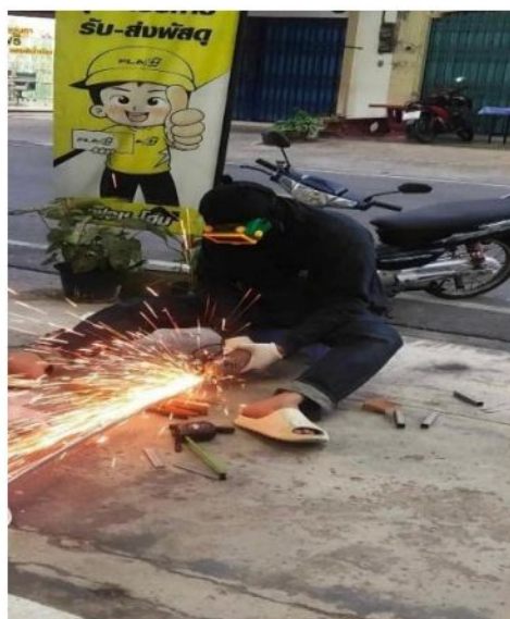
รูปที่ 3.25 ทำการตัดเหล็กโครงสร้างที่ได้วัดขนาดไว้
