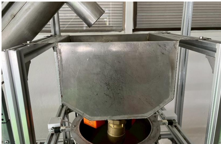
ภาพที่ 3-25 นำถังพักมาติดตั้งบนโครงอลูมิเนียมโปรไฟล์
