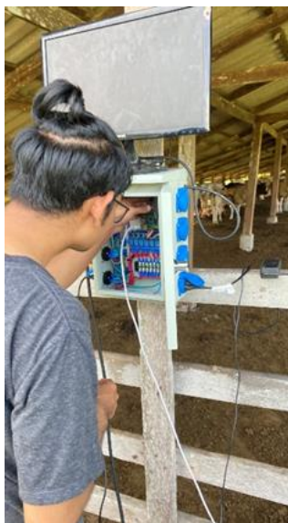
รูปที่ 3-11 ติดตั้งระบบในฟาร์ม
