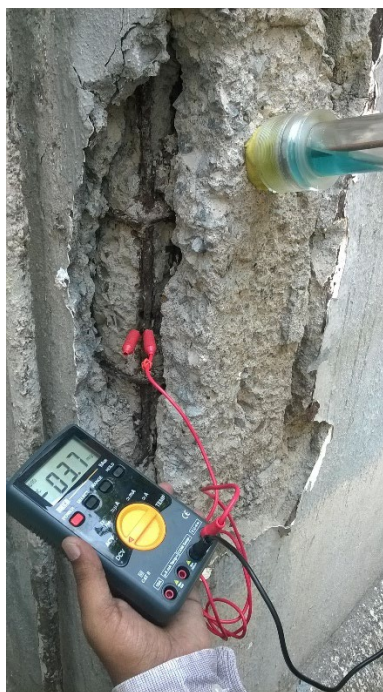
ภาพที่ 2-5 การวัดค่าศักย์ไฟฟ้าของเหล็กในโครงสร้างอาคาร
