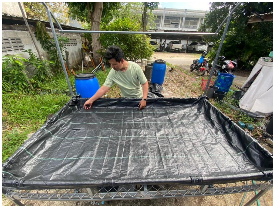
ภาพที่ 3.14 นำกระสอบที่ได้จากการเย็บมารองเพื่อพร้อมที่จะใส่ดิน
