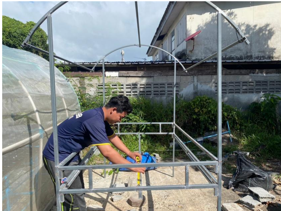
ภาพที่ 3.8 ทำการวัดระยะเพื่อตัดเหล็กในการประกอบโครงสร้าง
