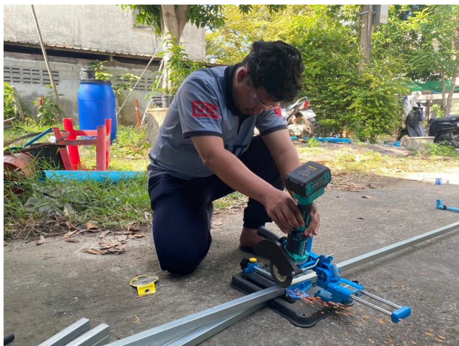
ภาพที่ 3.9 ทำการตัดเหล็กตามระยะที่ได้วัดไว้
