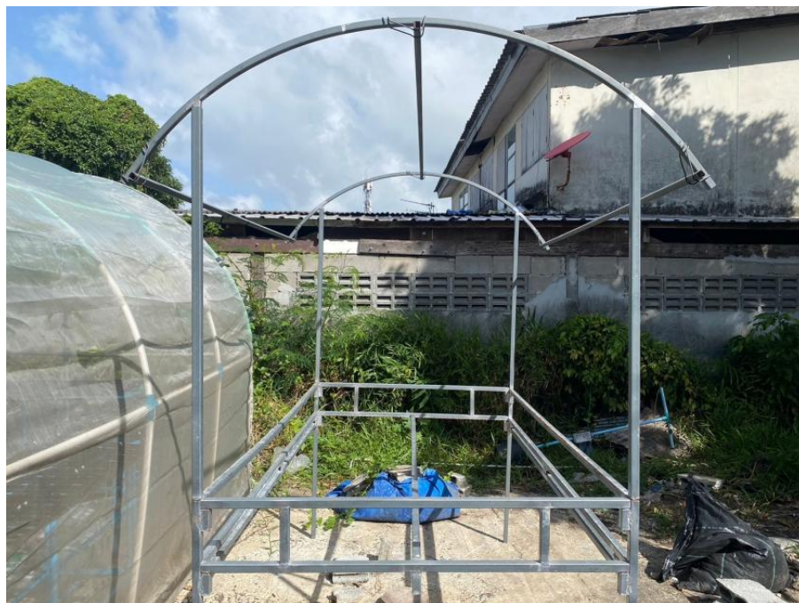
ภาพที่ 3.7 ภาพก่อนทำการเชื่อมเพื่อเสริมความแข็งแรง
