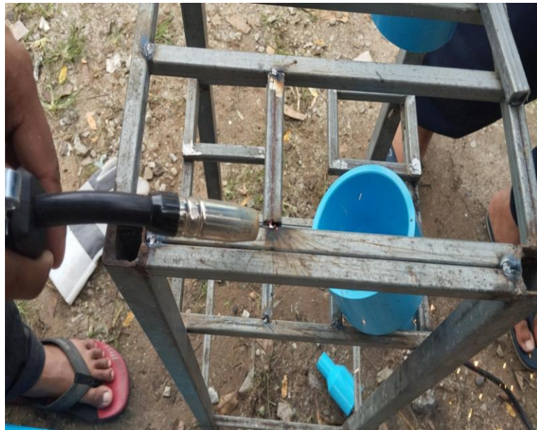
รูปที่ 3-33 เชื่อมเหล็กเพื่อประกอบเป็นโครงสร้างสำหรับล๊อคตัวถังน้ำมัน
