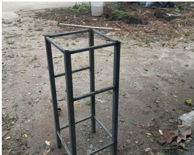
รูปที่ 3-22 วัดและตัดเหล็กให้ได้ขนาดตามแบบที่กำหนด และทำการเชื่อมประกอบโครงสร้าง
