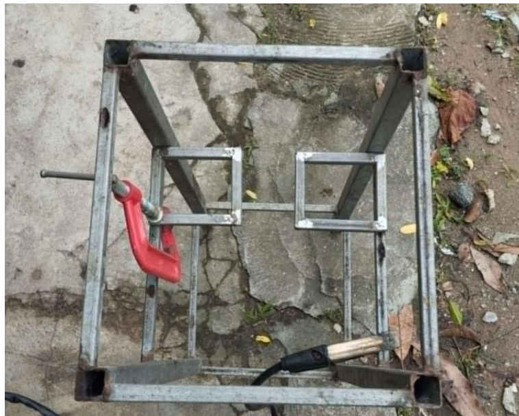
รูปที่ 3-27 เชื่อมเหล็กเพื่อประกอบเป็นโครงสร้างสำหรับรองรับน้ำหนักของถังน้ำมัน
