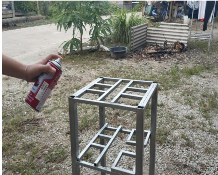
รูปที่ 3-40 พ่นสีโครงสร้างเหล็กที่ทำการเชื่อมประกอบแล้ว
