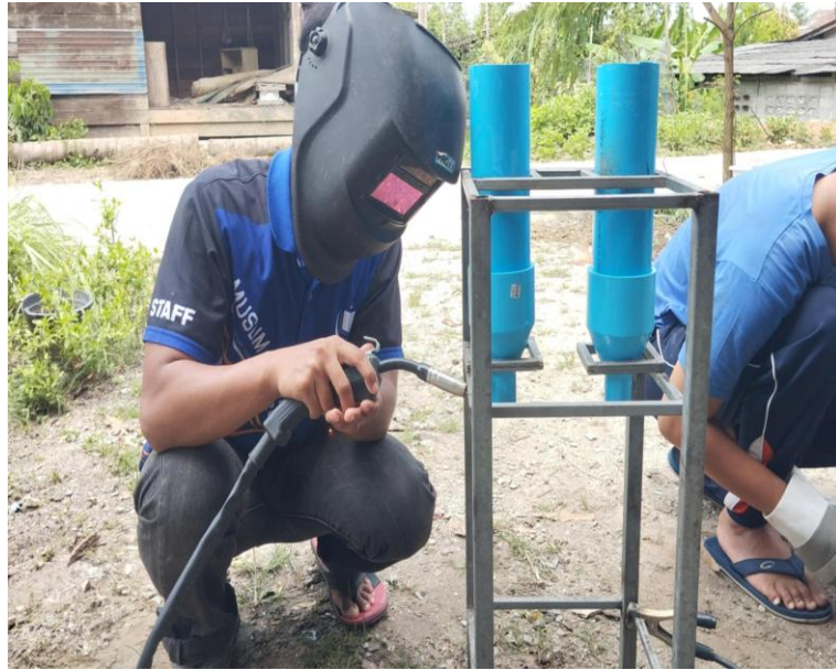
รูปที่ 3-34 เชื่อมเหล็กเพื่อประกอบเป็นโครงสร้างสำหรับรองรับน้ำหนักของถังน้ำมัน
