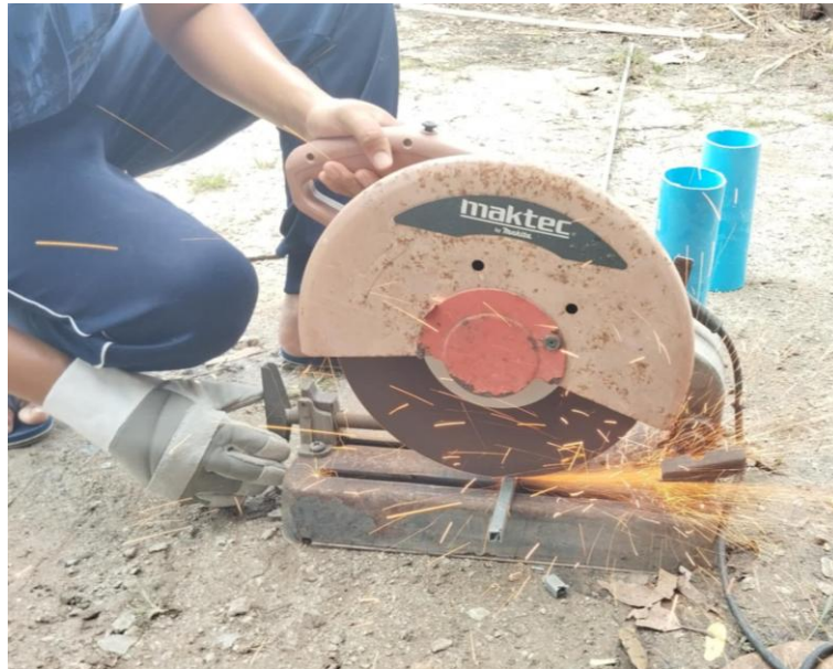
รูปที่ 3-24 ตัดเหล็กให้ได้ขนาดตามที่คำนวณไว้
