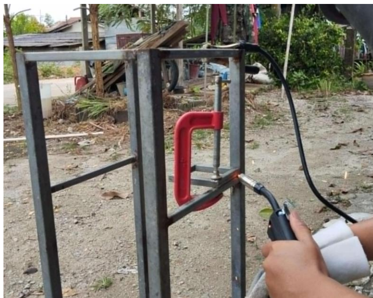
รูปที่ 3-25 เชื่อมเหล็กเพื่อประกอบเป็นโครงสร้างสำหรับรองรับน้ำหนักของถังน้ำมัน
