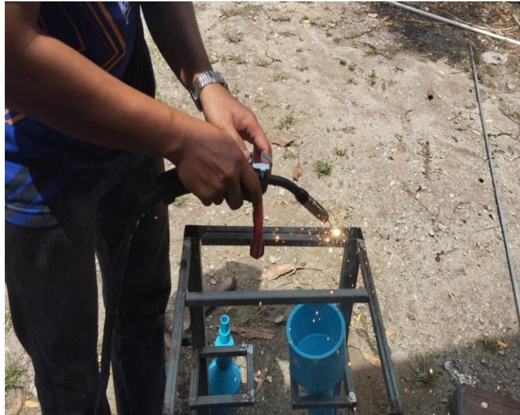
รูปที่ 3-30 เชื่อมเหล็กเพื่อประกอบเป็นโครงสร้างสำหรับล๊อคตัวถังน้ำมัน
