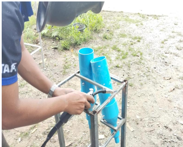
รูปที่ 3-31 เชื่อมเหล็กเพื่อประกอบเป็นโครงสร้างสำหรับล๊อคตัวถังน้ำมัน
