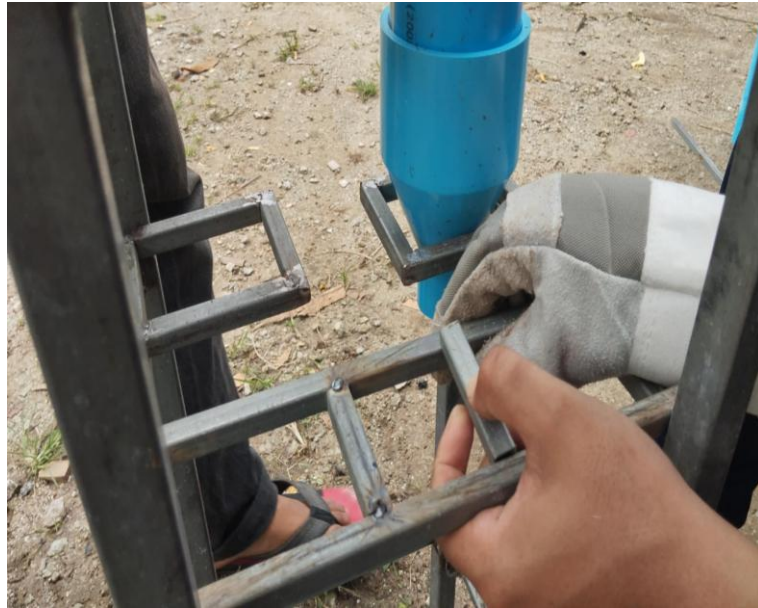
รูปที่ 3-38 เชื่อมเหล็กสำหรับใช้เป็นฐานรับน้ำหนักของถังใส่น้ำมัน
