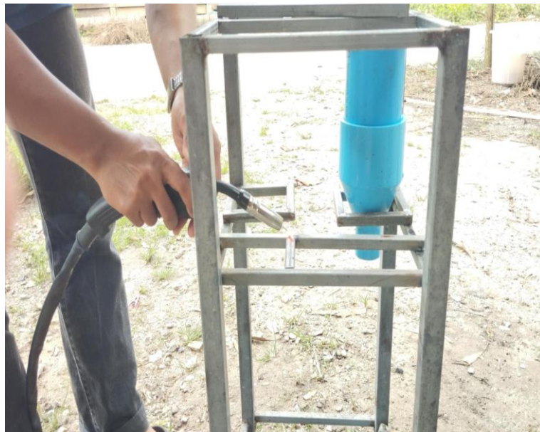
รูปที่ 3-37 เชื่อมเหล็กเพื่อประกอบเป็นโครงสร้างสำหรับรองรับน้ำหนักของถังน้ำมัน
