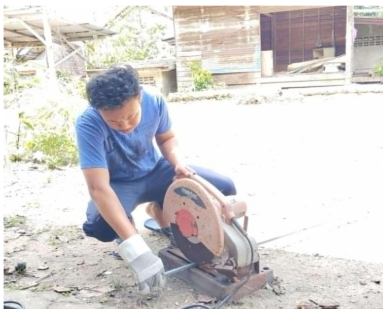
รูปที่ 3-23 ตัดเหล็กให้ได้ขนาดตามที่คำนวณไว้
