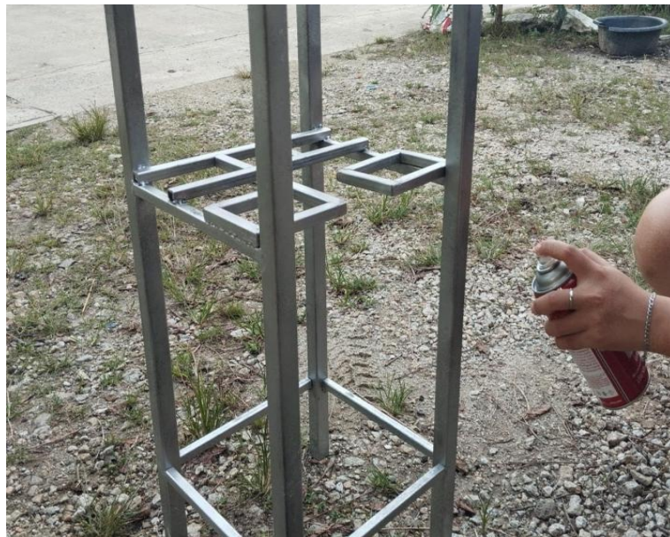
รูปที่ 3-41 พ่นสีโครงสร้างเหล็กที่ทำการเชื่อมประกอบแล้ว
