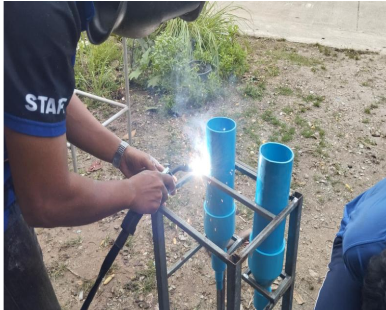
รูปที่ 3-32 เชื่อมเหล็กเพื่อประกอบเป็นโครงสร้างสำหรับล๊อคตัวถังน้ำมัน
