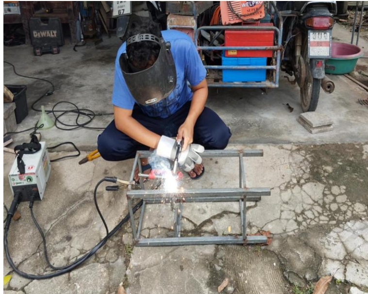
รูปที่ 3-28 เชื่อมเหล็กเพื่อประกอบเป็นโครงสร้างสำหรับรองรับน้ำหนักของถังน้ำมัน
