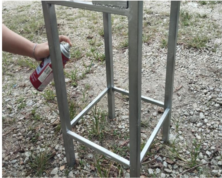
รูปที่ 3-42 ฟันสีโครงสร้างเหล็กที่ทำการเชื่อมประกอบแล้ว
