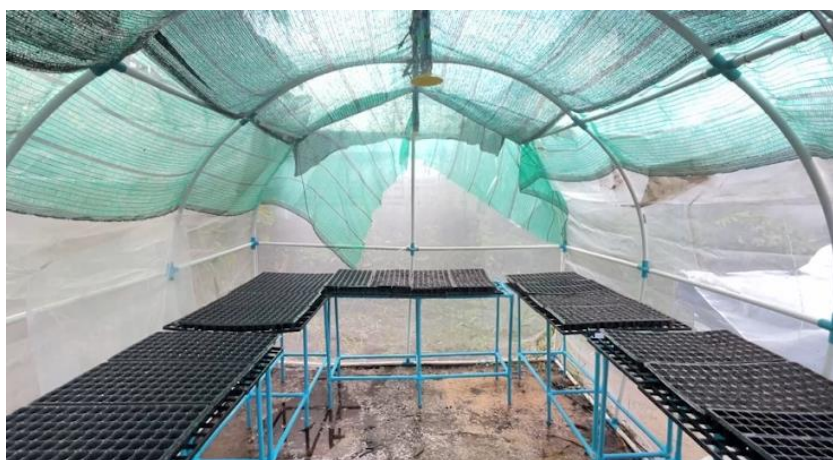
รูปที่ 3.11 ประกอบฐานวางถาดเพาะปลูกลำภายในโรงเรือน
