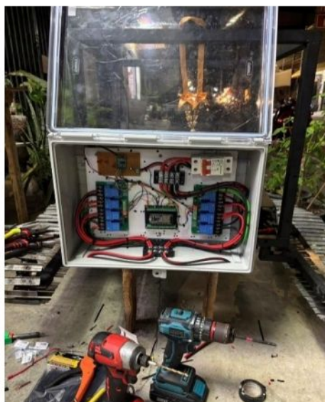
ภาพที่ 3-43 นำตู้ที่ใช้ติดตั้งอุปกรณ์คอนโทรลติดตั้งกับตัวรถ
