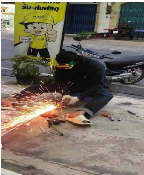
ภาพที่ 3-31 ทำการตัดเหล็กโครงสร้างที่ได้วัดขนาดไว้
