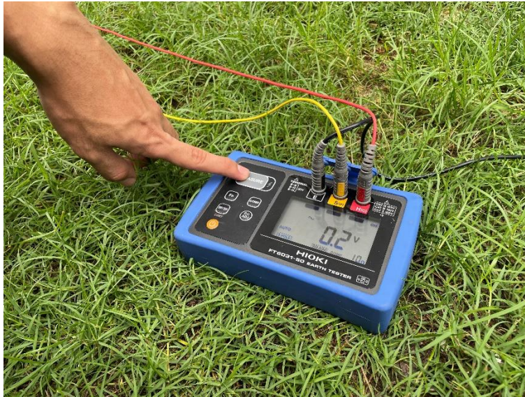
ภาพที่ 2-7 เมื่อนำสายทั้ง 3 ไปปักที่หมดจึงกดปุ่ม measure เพื่อทำการอ่านค่าความต้านทาน [3]
