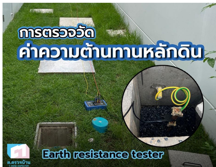
ภาพที่ 2-2 การตรวจวัดค่าความต้านทานหลักดินแบบเครื่องวัดความต้านในดินแบบปล่อยกระแสและแรงดันลงในพื้นที่ [3]
