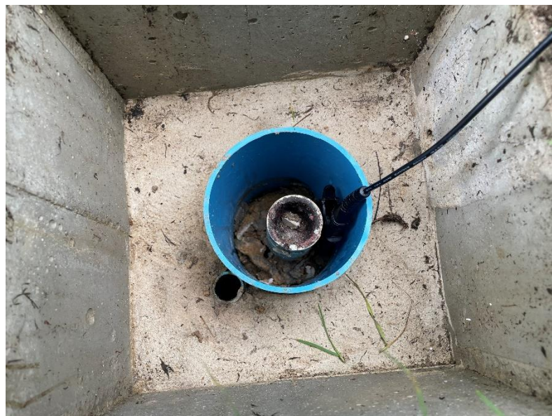
ภาพที่ 2-4 การตรวจวัดค่าความต้านทานหลักรดิน นำสายสีดำต่อกับเครื่อง [3]
