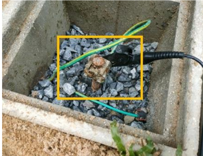
ภาพที่ 2-3 หลักรดินจะอยู่ในบ่อพักสายดิน [3]
