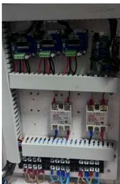
ภาพที่ 3-4 ต่อสายคอนโทรลเข้ากับอุปกรณ์ภายในตู้ควบคุม
