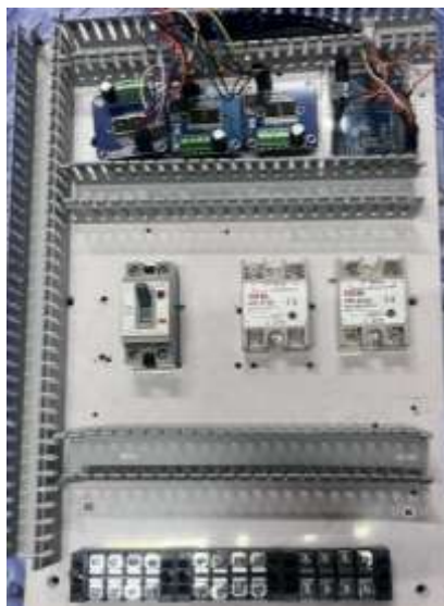
ภาพที่ 3-3 การติดตั้งอุปกรณ์เข้าสู่ตู้ควบคุม
