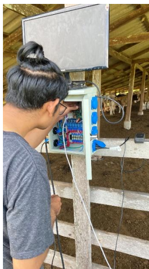
รูปที่ 3-12 ติดตั้งระบบในฟาร์ม
