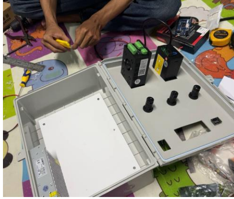
รูปที่ 3.40 ติดตั้ง VFD หลอด Led และ Power supply 12V 5A.
