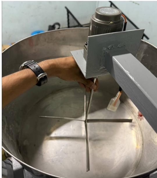
รูปที่ 3.34 ทำการติดตั้งใบพัดกับเฟลมอเตอร์ตัวที่ 1
