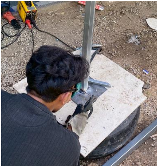
รูปที่ 3.30 ทำการเชื่อมที่ยึดมอเตอร์ตัวที่ 1
