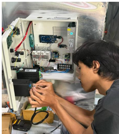
รูปที่ 3.43 ติดตั้งตู้ควบคุม และเดินสายภายในตู้ควบคุม
