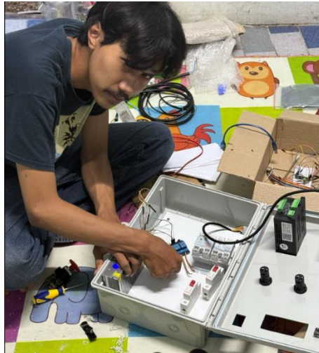
รูปที่ 3.41 หาตำแหน่งวางเบรกเกอร์ บอร์ด และ Relay ภายในตู้
