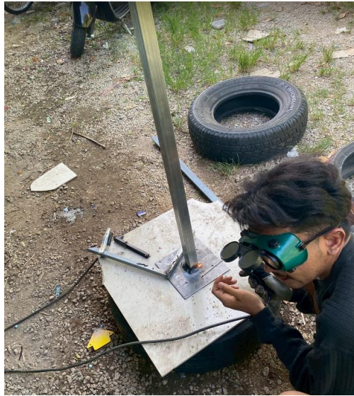
รูปที่ 3.32 ทำการเชื่อมขายึดมอเตอร์ตัวที่ 2
