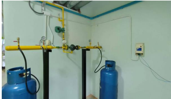
รูปที่2 : ระบบแก๊สภายในร้านซักอบแห้ง
